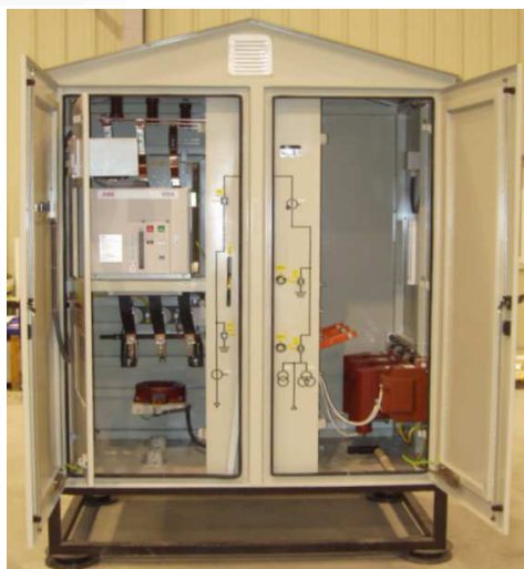
Varianty usazení výrobku (volitelné příslušenství) - na silentbločích (pružné uložení)
