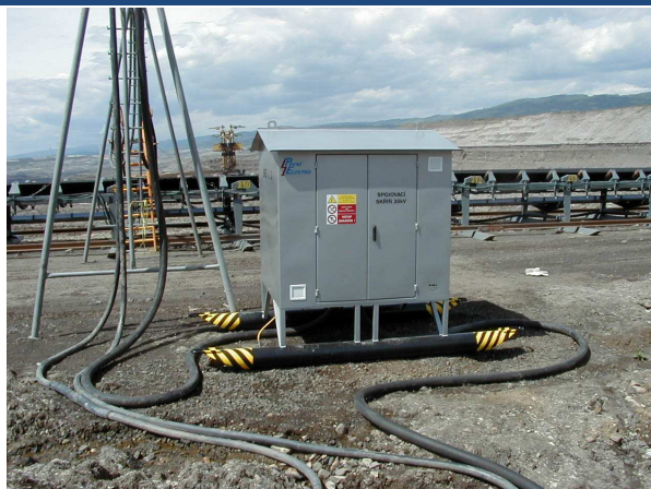
Standardní použití výrobku pro spojování vlečných kabelů 35kVv podmínkách povrchového dolu
