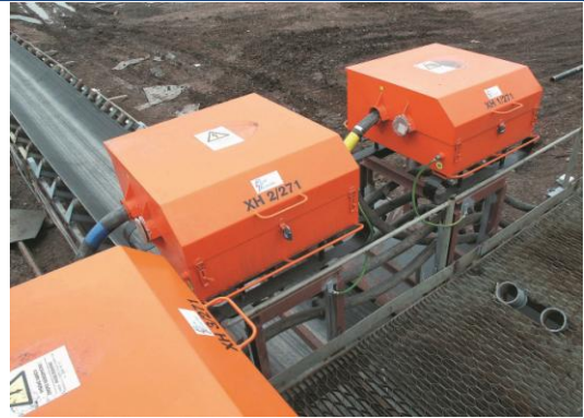
Montáž spoj. skříně na poháněcí stanici PD
